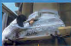
SANCTI MARCI DELLE GRAZIE Restauro con ricostruzioni parziali e sigillature, trattamenti protettivi del colonnato in arenaria.
