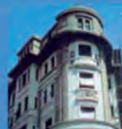
PALAZZO D'EPOCA IN MILANO Pittura, ripristini strutturali estetico-decorativi e riprofilature su "marmo apollino" fortemente degradato.
