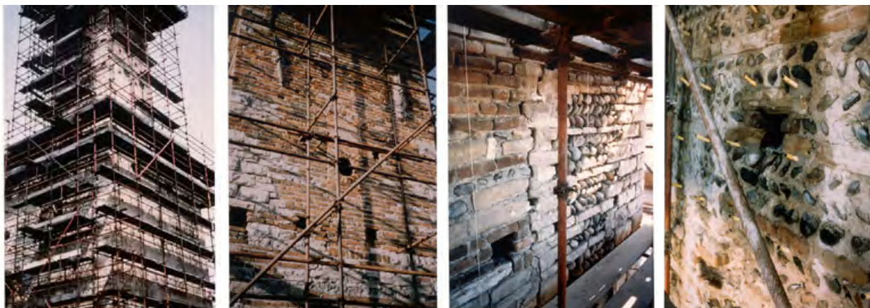
Dopo il restauro
