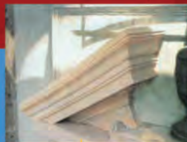
PALAZZO D'EPOCA IN MILANO Pittura, ripristini strutturali estetico-decorativi e riprofilature su "marmo apollino" fortemente degradato.
