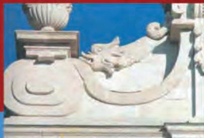
S. PROLO D'ANON XVI SECOLO Pittura, ricostruzioni e sigillature su marmo Zandobio con trattamenti protettivi finali.
