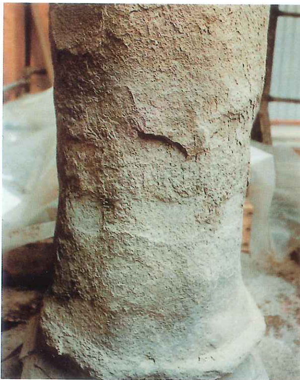
Fig. 11 Erosione alla base di una colonna d'arenaria quarzoso-feldspatica con cemento calcitico
