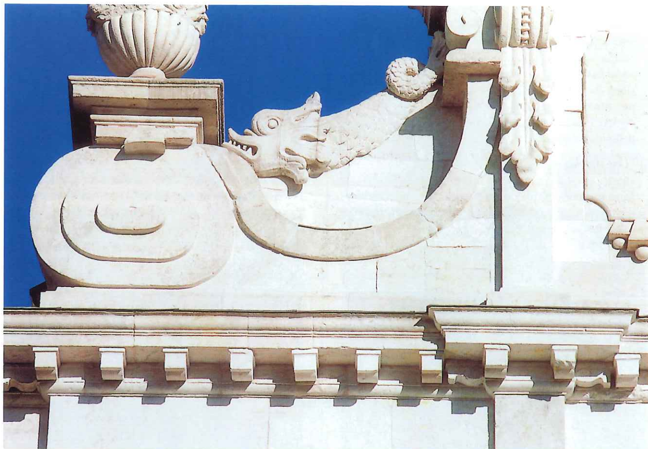
S. PAOLO D'ARGON - Particolare della facciata principale a restauro ultimato (1987)
