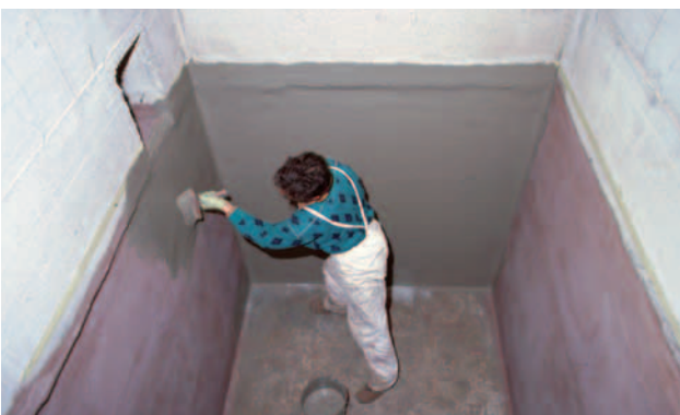
9 APPLICAZIONE DEL TECNOSEAL V1 GRIGIO
