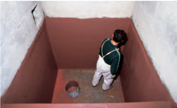
7 APPLICAZIONE ULTIMATA DEL TECNOSEAL V1 ROSSO
