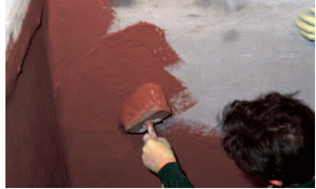
6 APPLICAZIONE DI TECNOSEAL V1 ROSSO
