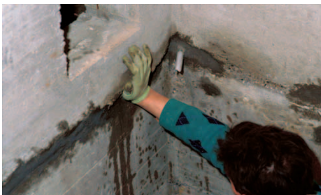
3 IDEM CON APPLICAZIONE DI TUBO DI DRENAGGIO
