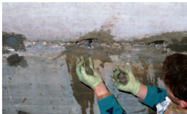
2 APPLICAZIONE DEL TECNOSTOP PER FERMARE LE VENUTE D'ACQUA
