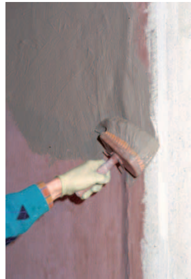
8 APPLICAZIONE DEL TECNOSEAL V1 GRIGIO
