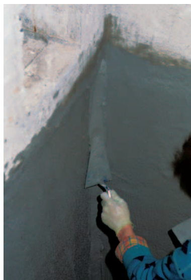
4 FORMAZIONE DI GUSCE CON MuCis ® BS 38 BICOMPONENTE
